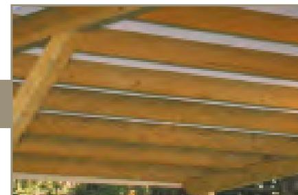
Il CarBox legno + pvc modello light è la soluzione ideale per chi ha esigenza di creare due comodi posti auto riparati dalla pioggia pur non rinunciando alla luce. Il telo in PVC è infatti montato a copertura della struttura in abete lamellare realizzata completamente ad incastro ed impregnata in autoclave.
